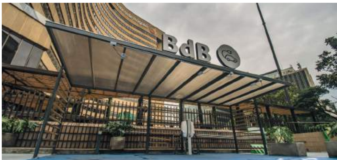
Parqueadero sostenible en la Dirección General Banco de Bogotá.
